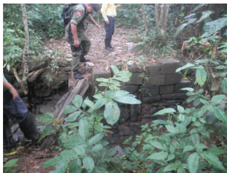
Foto 40: Caixa d'água da Pirelli. Fonte: Instituto Avaliação (2017).
